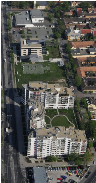
Tél utca beépítése
