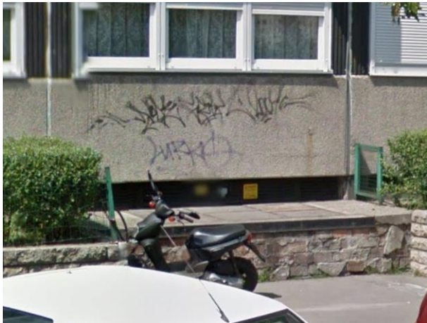
3399 sz. épületben elhelyezett 10/0,4 kv-os transzformátor, Rózsa utca
