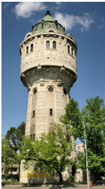
Üzemen kívüli Árpád úti víztorony
