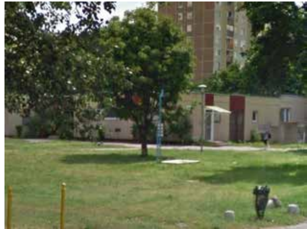
Földbe süllyesztett körzeti gáznyomásszabályzó a Viola utcánál
