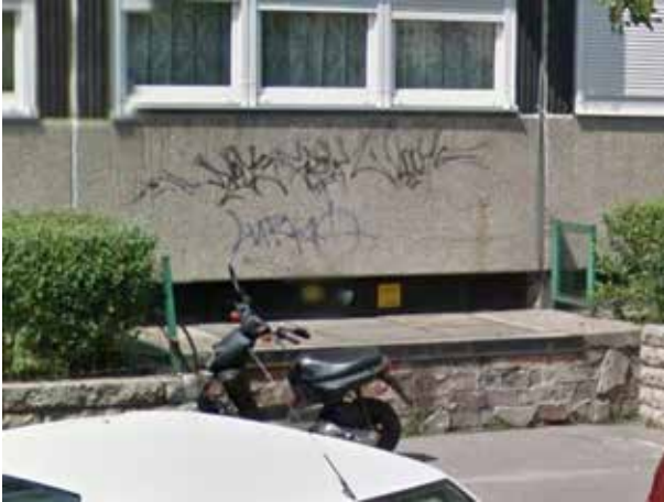
3399 sz. épületben elhelyezett 10/0,4 kV-os transzformátor, Rózsa utca
