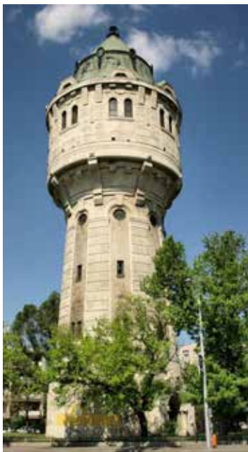
Üzemen kívüli Árpád úti víztorony
