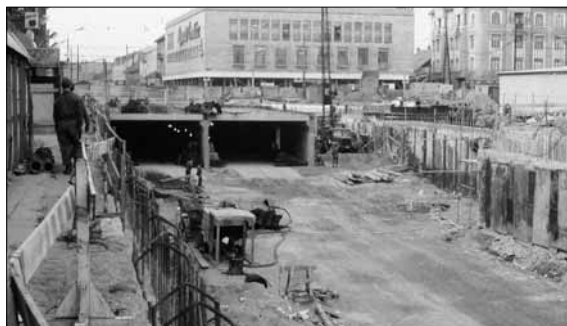
Munkagödör és a megépített aluljárószakasz 1987-ben
