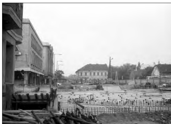
Az aluljáró vasbeton födém-szerkezetének és kijáratainak készítése (A szerző felvétele)
