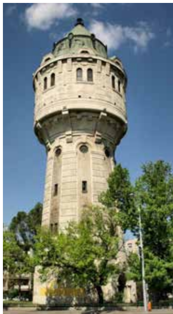
Üzemen kívüli Árpád úti víztorony
